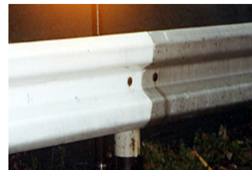
防汚・セルフクリーニング応用製品 (光触媒塗料を塗装したガードレール)
